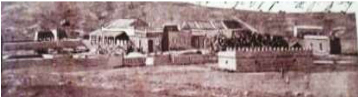
Gibeon 1912 Wasserturm und Mission
